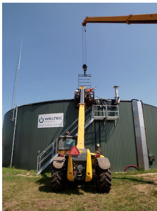
Obr. 32: výměna míchadla
