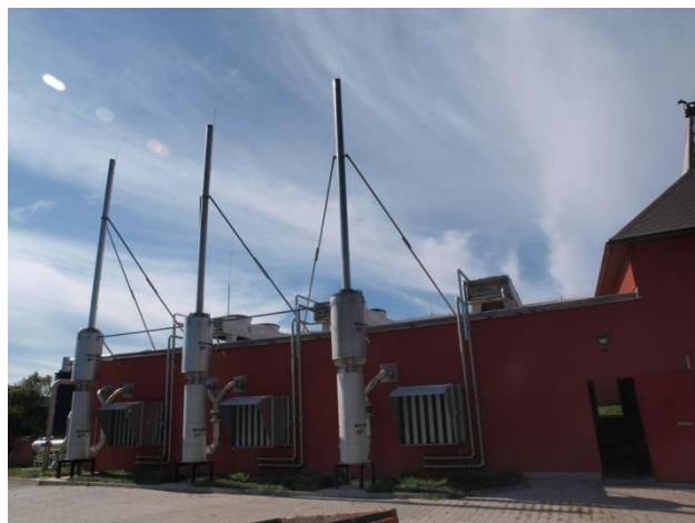
Obr. 23: výfuky a průduchy chladičů
