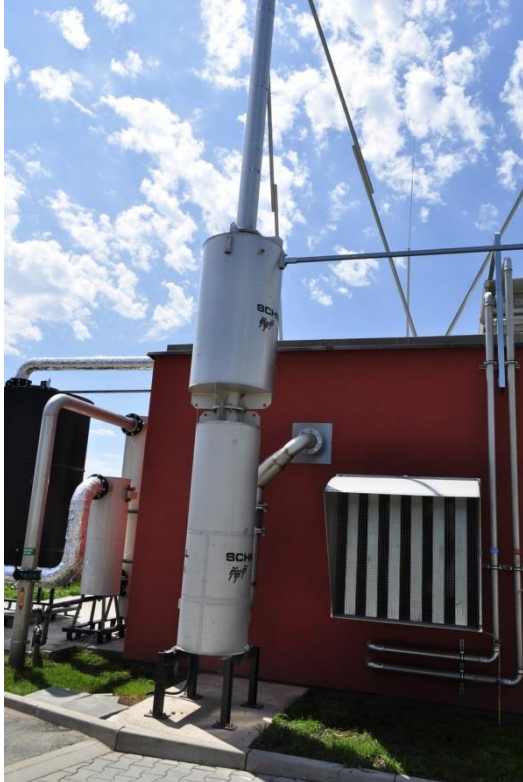
Obr. 27: před instalací teplovodu
