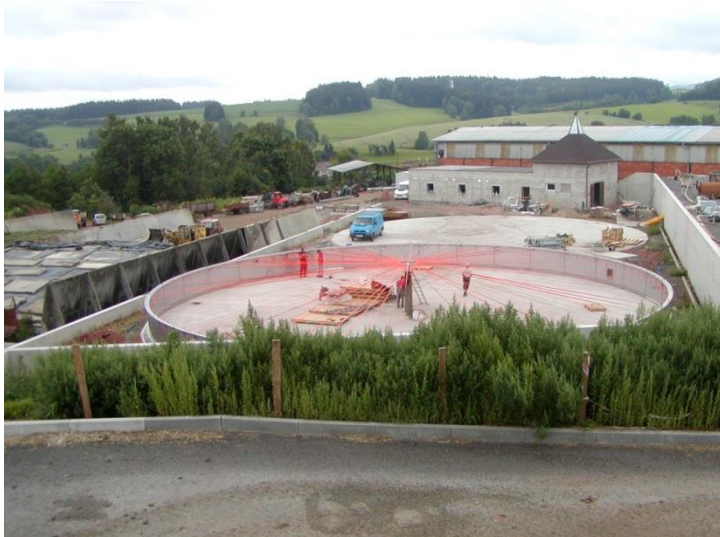
Obr. 12: pohled na rozestavěnou BPS v Bělé
