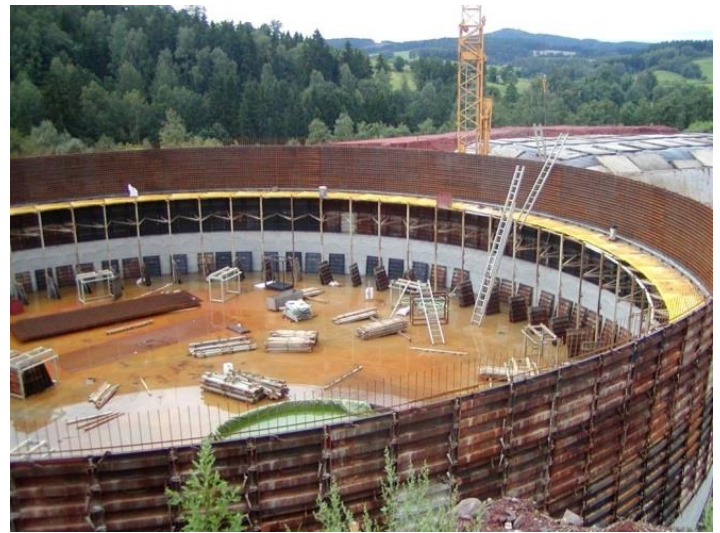
Obr. 14: pohled do rozestavěné koncové jímky
