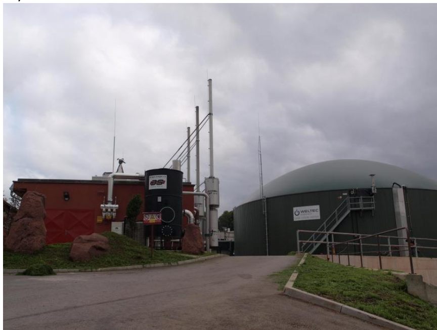
Obr. 2: pohled na BPS Bělá
