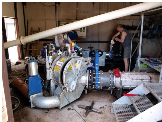
Obr. 34: montáž čerpadla
