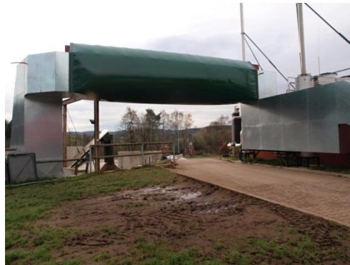
Obr. 28 a 29: po instalaci teplovodu
